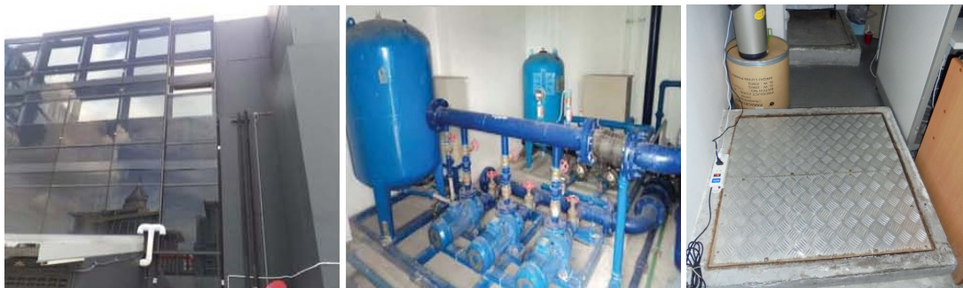
3-6 ถึงสํารองน้ำใช้ชั้นคาเฟ่ และปั๊มสูบน้ำแรงดันสูง และถึงสํารองน้ำใต้ดิน
