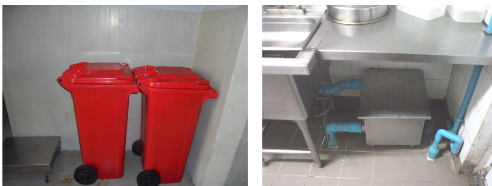
3-7 ถึงขยะติดเชื้อและถังดักไขมันบริเวณห้องครัว
